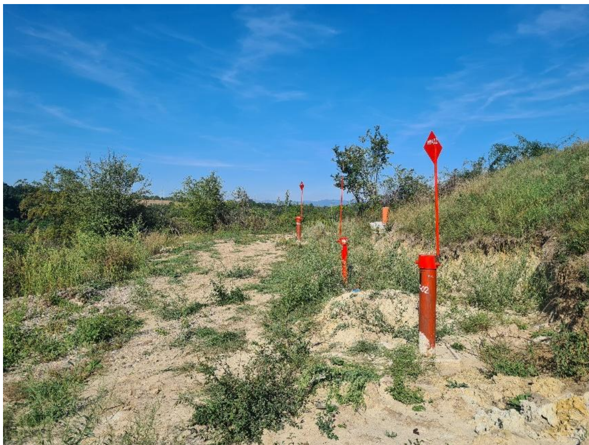
Snímek č. 2 Pohled na vybudovaný systém monitoringu u budoucí mostní opěry (inklinometrický vrt, dva hydrologické vrty do první a druhé terciérní zvodně a geodetický bod)
